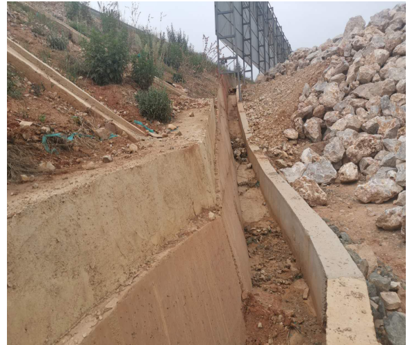
项目西南角截排水沟
