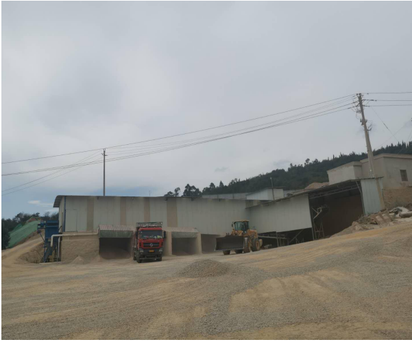
技改项目封闭式破碎筛分车间
