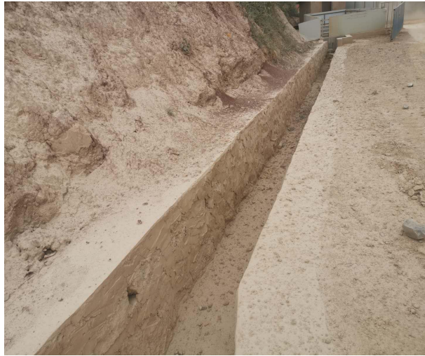
厂区门口截排水沟
