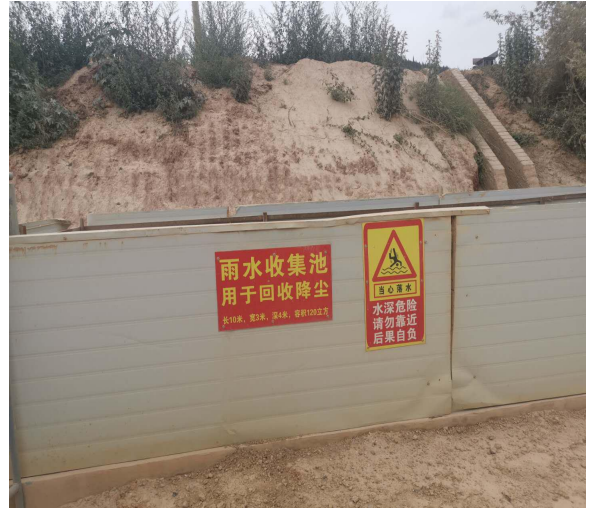
厂区门口初期雨水收集池（120m 3 ）
