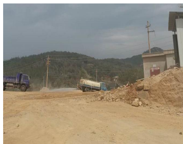
项目场地洒水降尘
