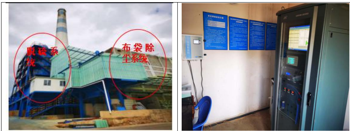
废气除尘、脱硫系统及废气排气筒
