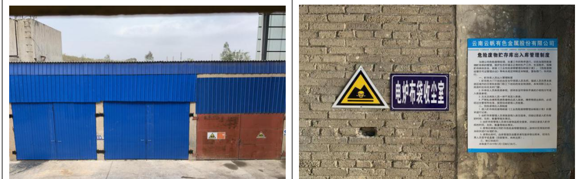
1#、2#、3#危险废物暂存库
