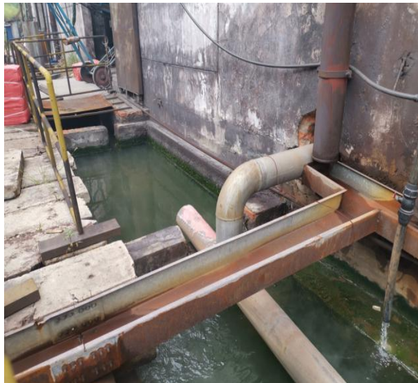
项目生产设备冷却水循环水池
