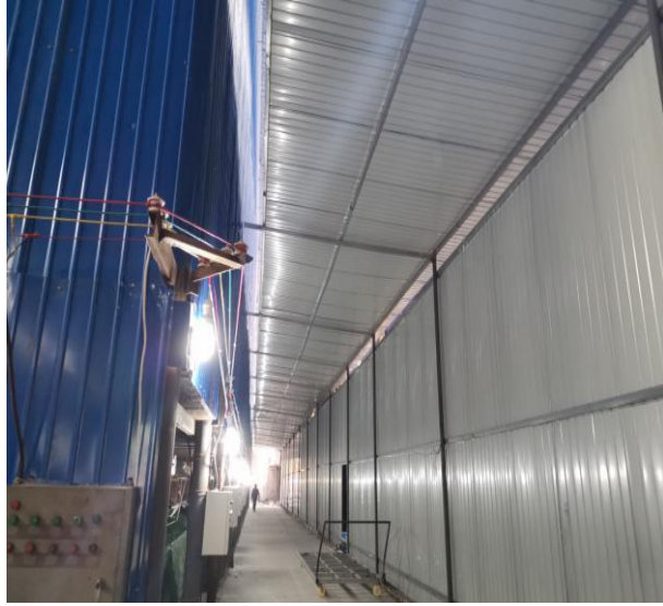
项目车间厂房
