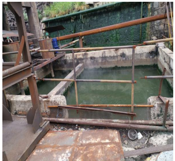
项目生产设备冷却水循环水池
