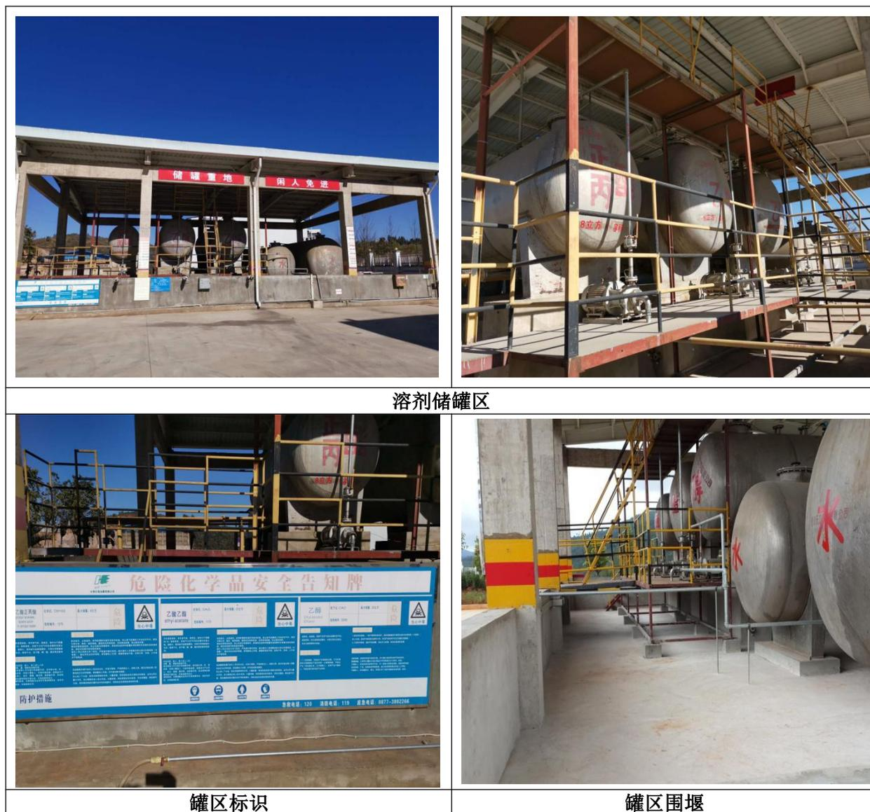
图 4-11 场地内溶剂罐区现场图片
