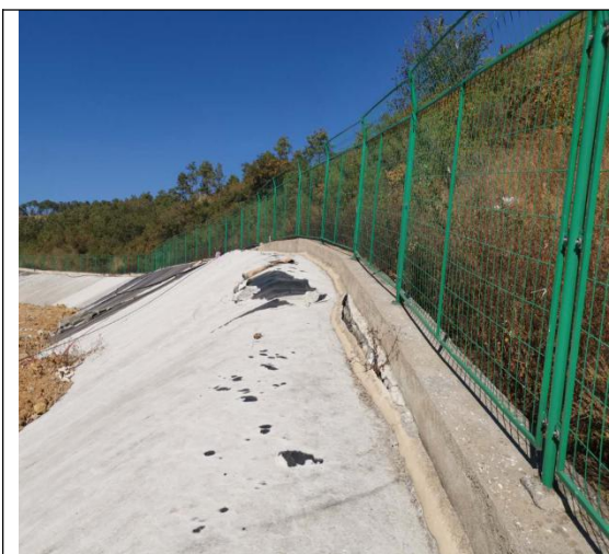
填埋区防火隔离带、防飞散网
