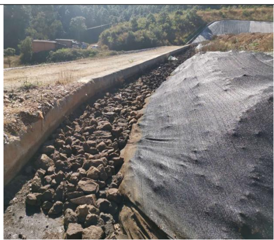
垃圾填埋场坝体渗滤液整改后图片
