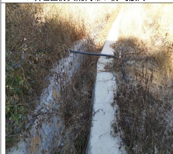
调节池沿线浆砌石永久截洪沟
