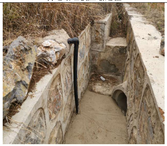
垃圾填埋场截排雨水沟整改后图片
