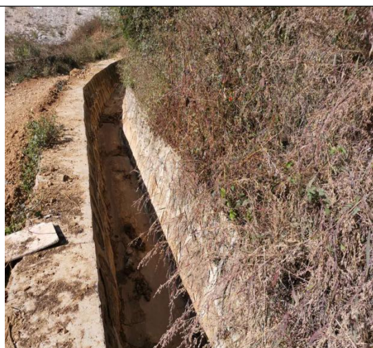
填埋场沿线浆砌石永久截洪沟
