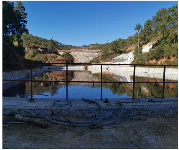
渗滤液调节池
