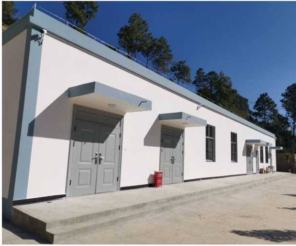
渗滤液处理站概貌
