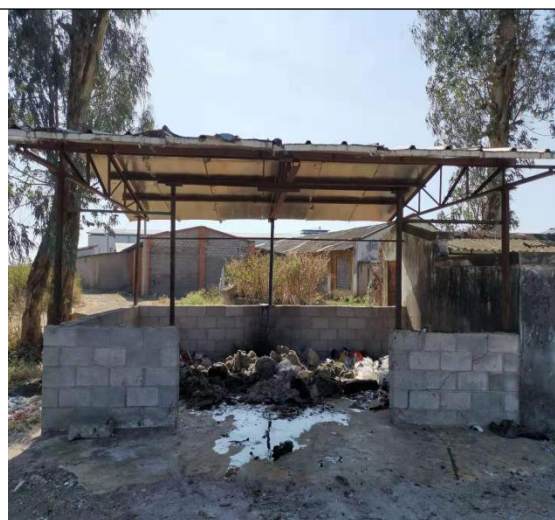
生活垃圾收集池
