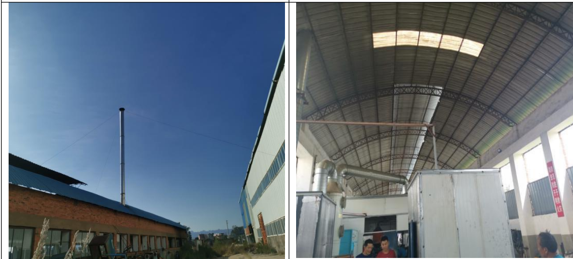
项目“集气+喷淋+低温等离子体+光氧催化+活性炭吸附”废气处理设施概貌
