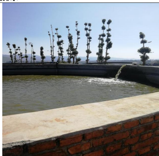
回用清水蓄水池（回用水取水点）
