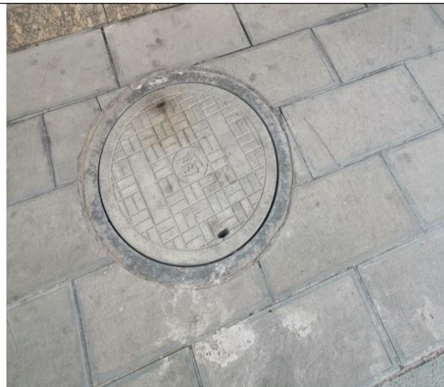
南涧县汽车客运站雨水管网
