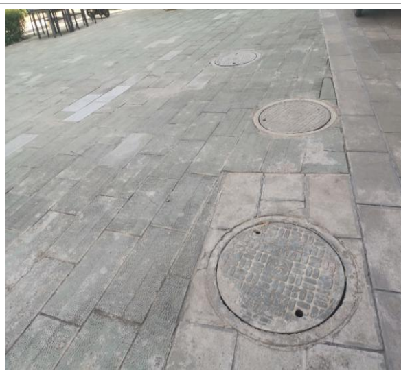
南涧县汽车客运站废水总排口
