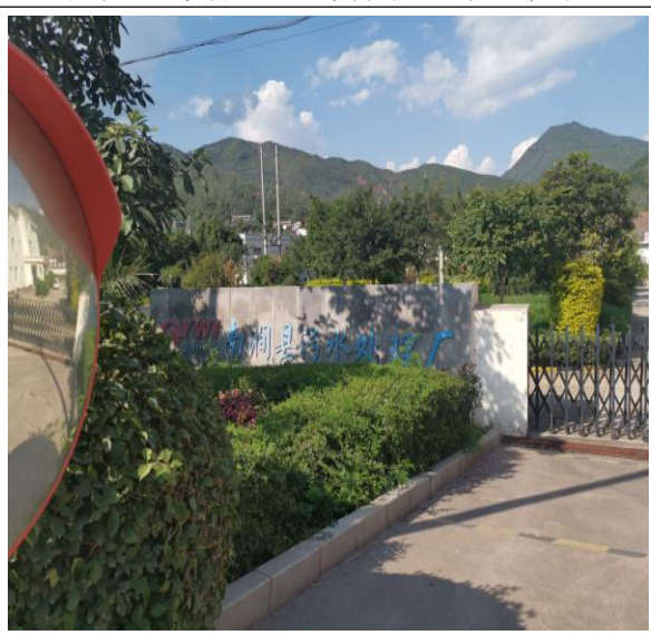
南涧县污水处理厂----距离南涧县汽车客运站 直线距离 170 米
