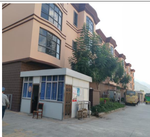
南涧县汽车客运站附属用房（化粪池为地埋式）
