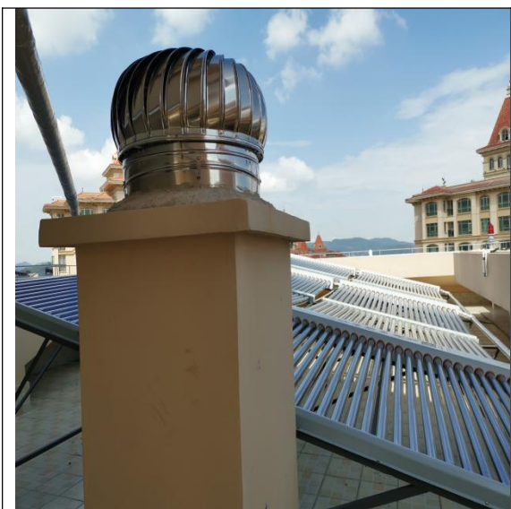
项目（A2 地块）住宅楼油烟管道
