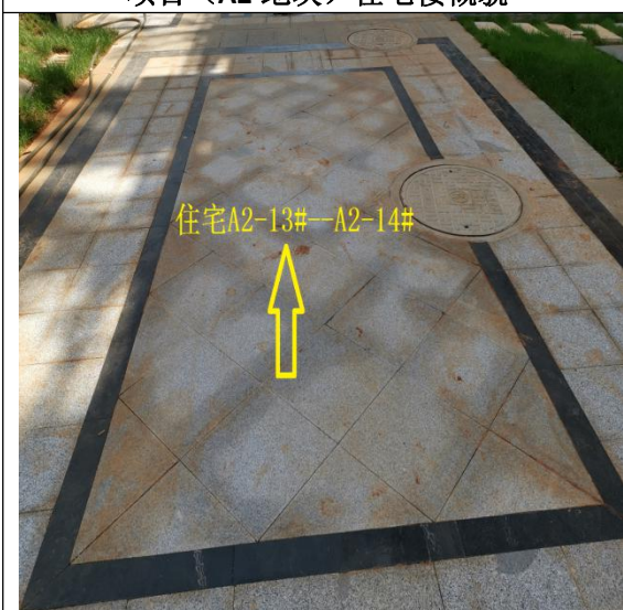
项目（A2 地块）化粪池 A
