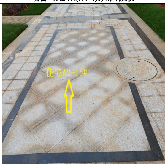
项目（A2 地块）化粪池 B
