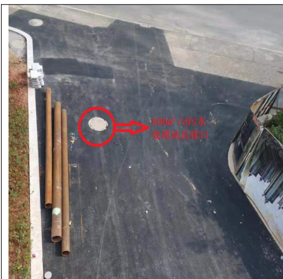
项目 (A3 地块) 800m 3 /d 污水处理站总排口
