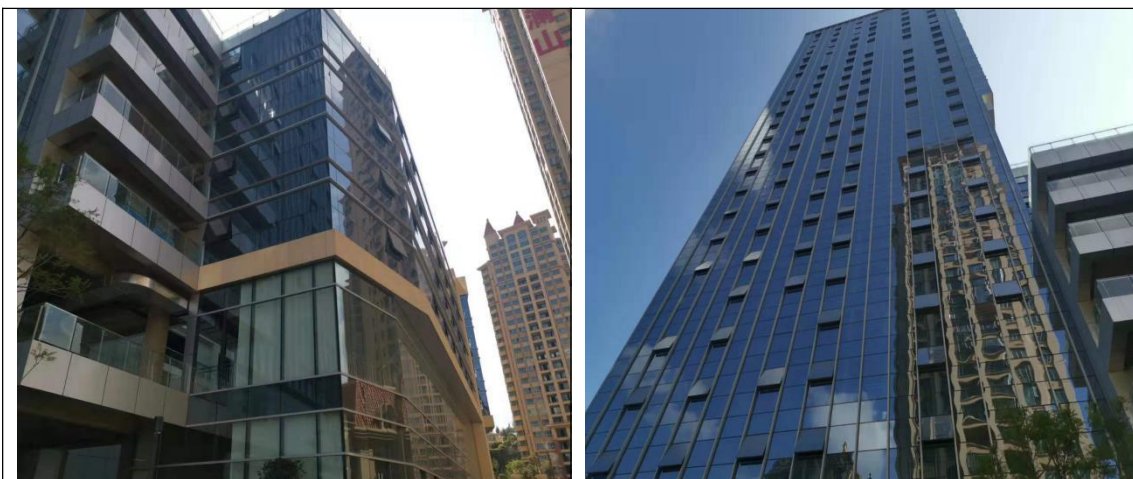
项目（A3 地块）综合楼概貌
